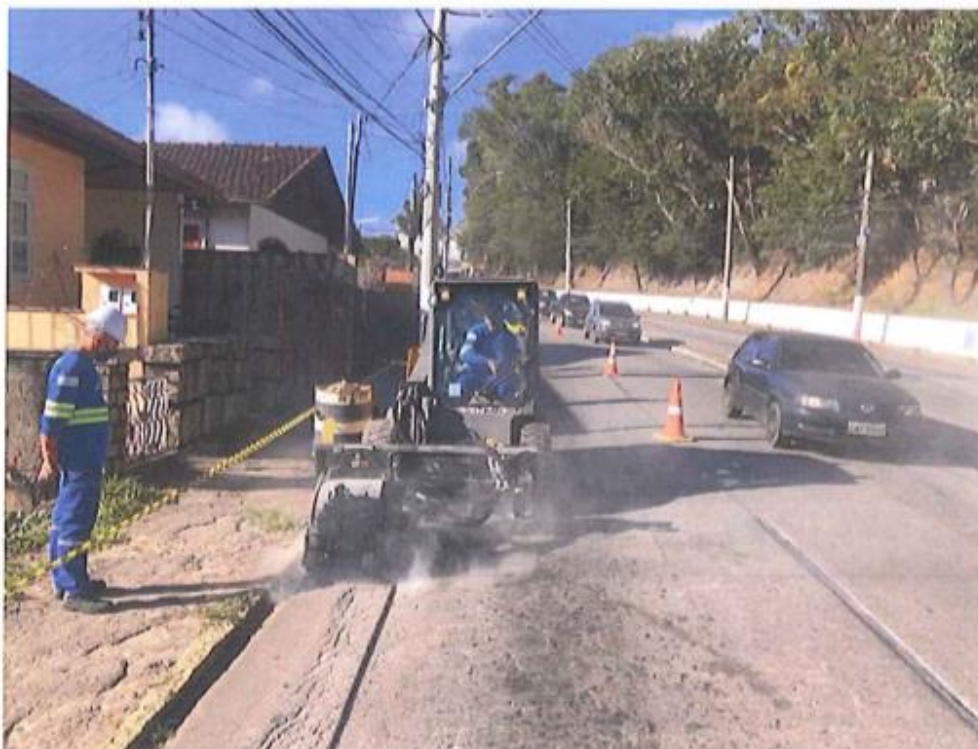
Figura 126 Equipe da concessionária executando serviços de manutenção na RJ 116
