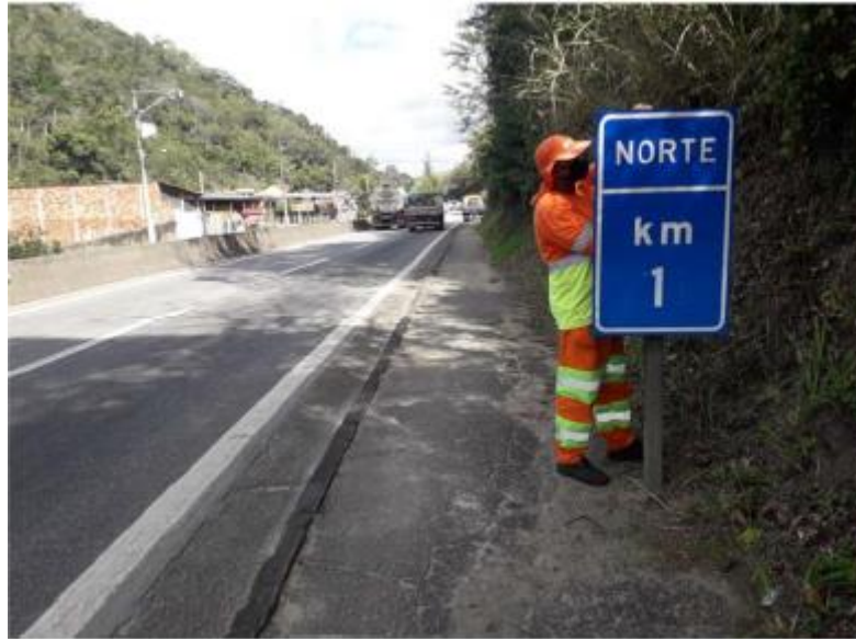
Figura 111 Substituição de Placa, Km 1
