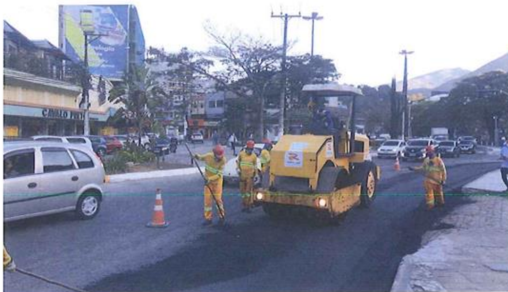
Figura 130 Equipe da concessionária executando serviço de manutenção de via
