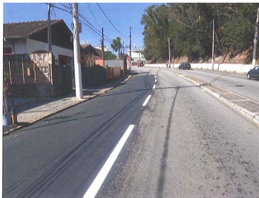
Figura 121 Serviço de Manutenção realizado na RJ 116
