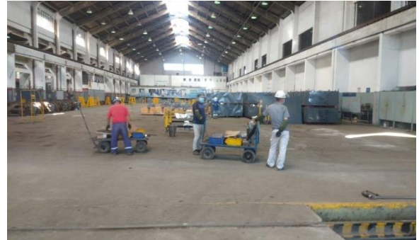
Figura 46 – Manutenção de trens da série 3000 na oficina de Deodoro
