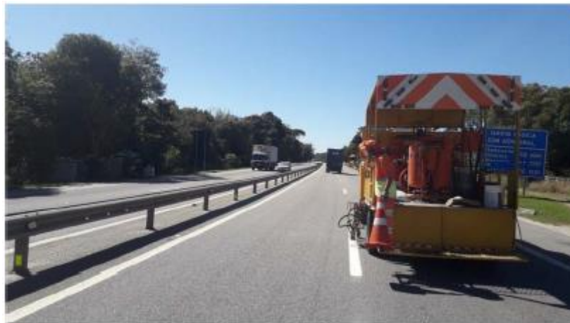
Figura 108 Pintura de Faixa, Km 20+500 Norte Faixa 1
