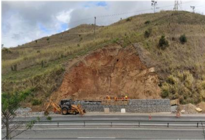
Figura 119 Obra de recuperação de talude
