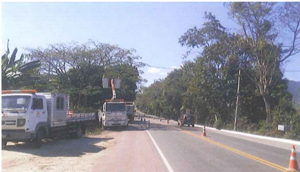
Figura 124 Serviço de manutenção na RJ 116
