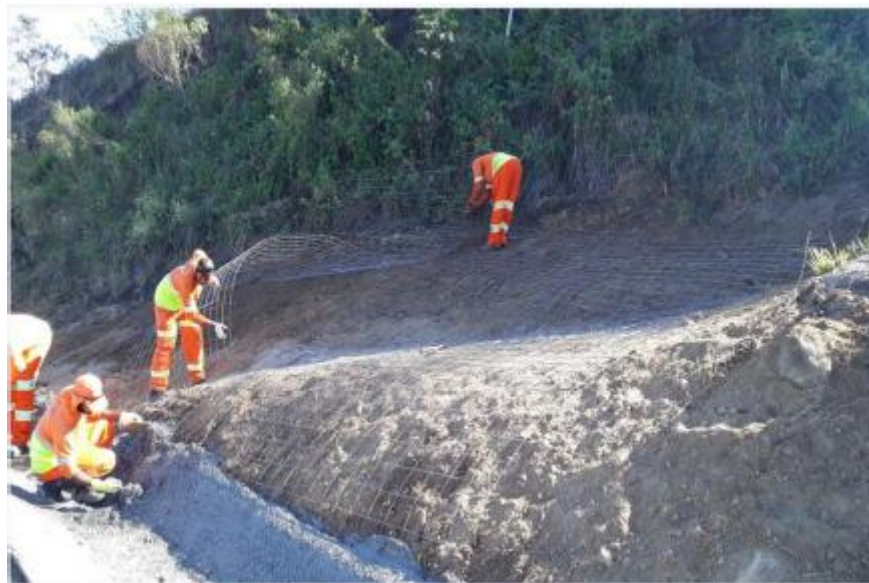
Figura 117 Drenagem de talude
