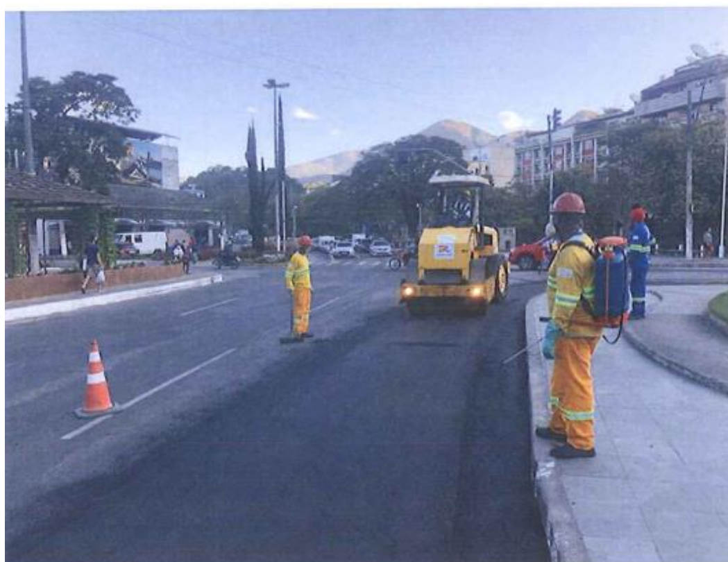
Figura 131 Equipe da concessionária executando serviços de recapeamento asfáltico na RJ 116
