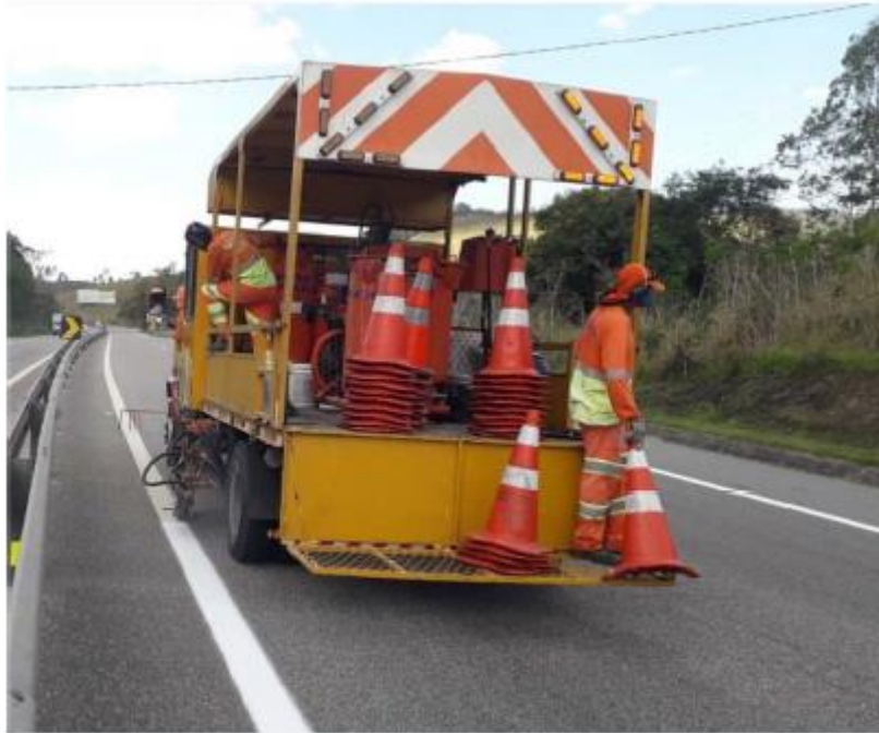
Figura 109 Pintura de Faixa, Km 20+500 Faixa 2
