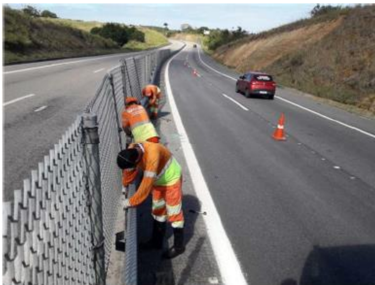
Figura 115 Reparo de dispositivo de segurança
