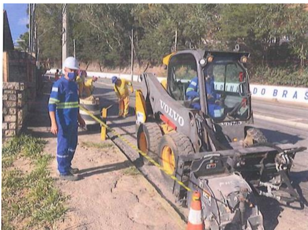
Figura 125 Serviço de reparo na RJ 116
